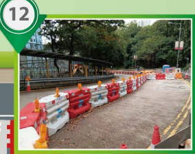
12 雙鳳街 Sheung Fung Street
